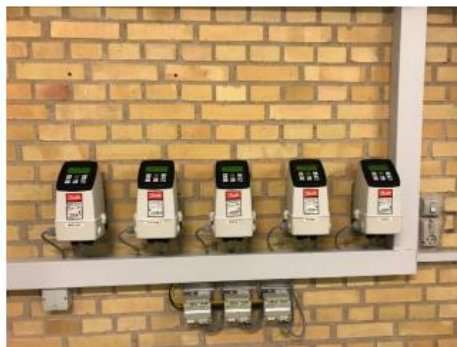
Vandmålere (råvand og rentvand)
