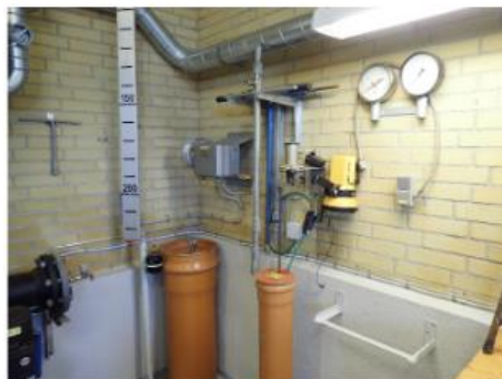
Niveaumåler ved rentvandstanken
