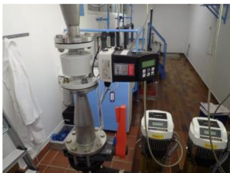
Vandmåler og tilgang fra Værebros Vandværk
