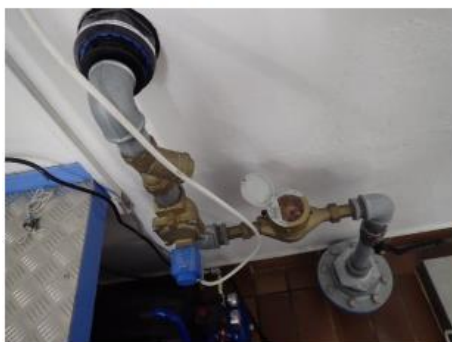
Vandmåler og tilgang fra Værebros Vandværk
