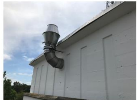
Tilførsel af filtreret luft i iltningstårn
