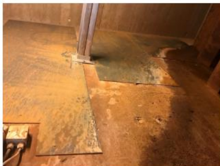
Indvendig aflukning af tidl. Ventilation
