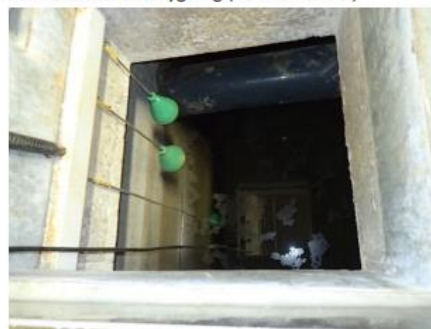
Rentvandstank u. bygning (med kalksvæv)
