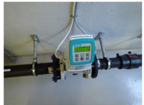
Svagt punkt ved mekanisk føler
